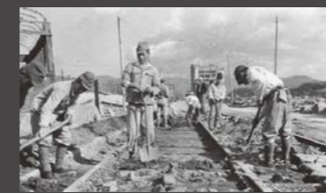
路面電車の線路の復旧に従事する人々 1945年（昭和20年）10月 菊池俊吉撮影 田子ほるみ提供
