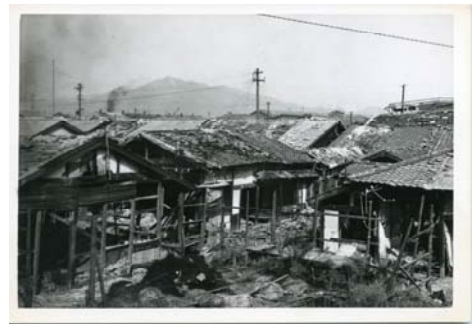
爆風で屋根瓦が吹き飛ばされた木造家
