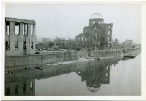
爆心地から約300m 相生橋から南東を望む
